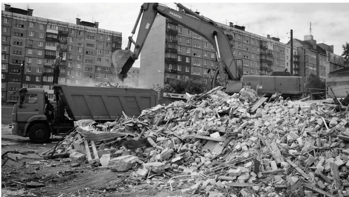
Рис.2. Вывоз строительного мусора строительной техникой
